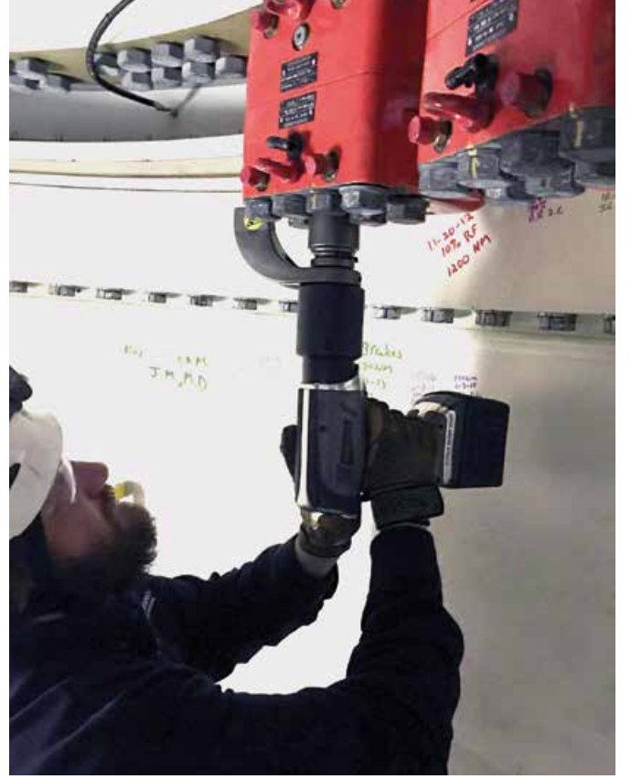
↑ BTM-700 Rüzgar Enerjisi Santrallerinde kullanım
