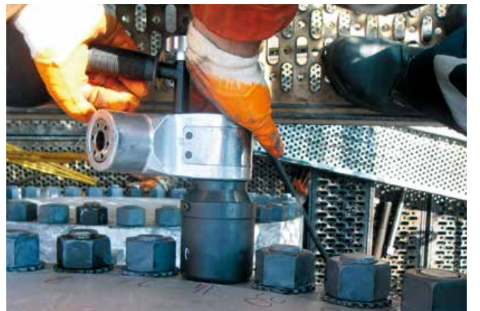
↑ zWasher ve AVANTİ-3 ile Flanş montajı
